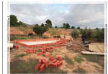
Construcción del estanque con base de malla y hormigón.
