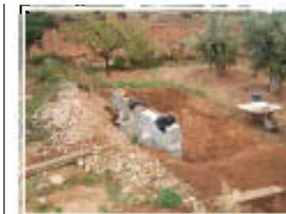
Comienzo de la construcción del estanque.
