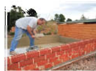
Finalizado del estanque.
