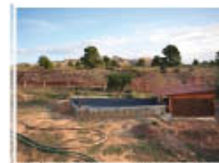
Vista del conjunto antes de llenar el bebedero de agua.
