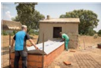
Construcción del hide bebedero de reflejos
